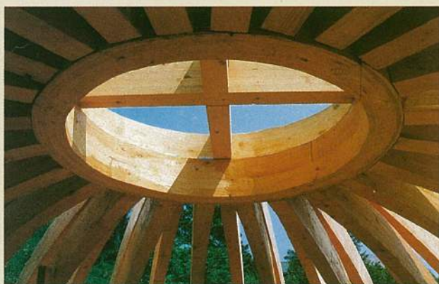
A kupola építés közben / The dome under constuction
