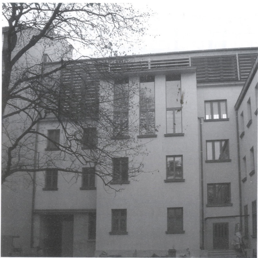
6. ábra. Az átépített udvari homlokzat
