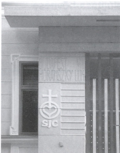
2. ábra. Előregyártott finombeton nyíláskeret
