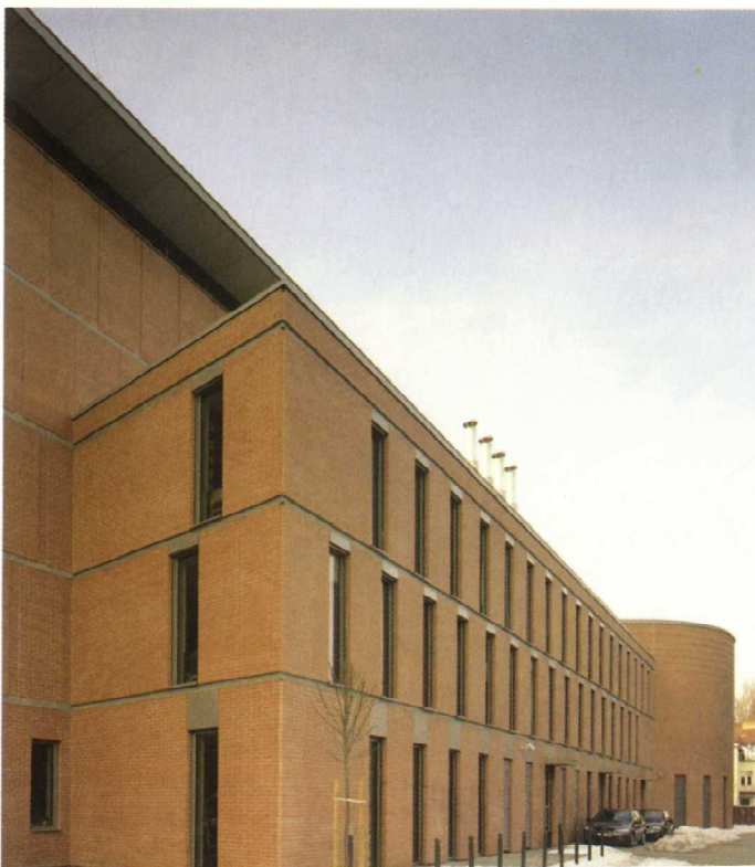
Jól elkülönülnek egymástól a tömör és a transzparens felületek. Az épület Zászló utcai sávjában a tömör homlokzatok mögött helyezkednek el a gépészeti és kiszolgálóterek, a raktárak, valamint a homlokzatból szegmensíves konzollal kinyúló konferenciaterem
