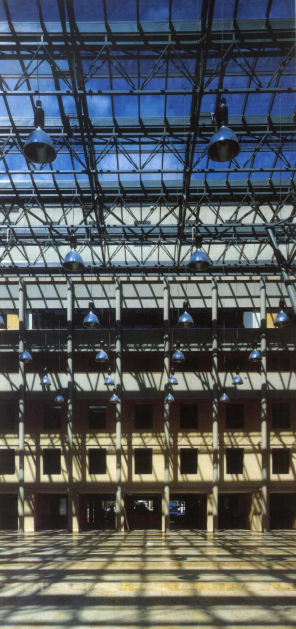
Láncra függesztett rácsos tartók kompozíciója
