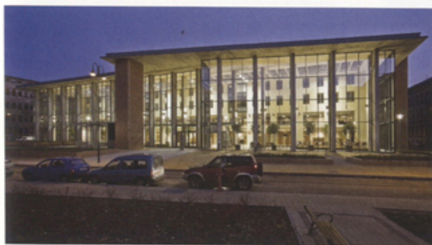
Színezett betonlapokkal burkolt, a főhomlokzat mellett kissé erődszerűen ható oldalhomlokzat
