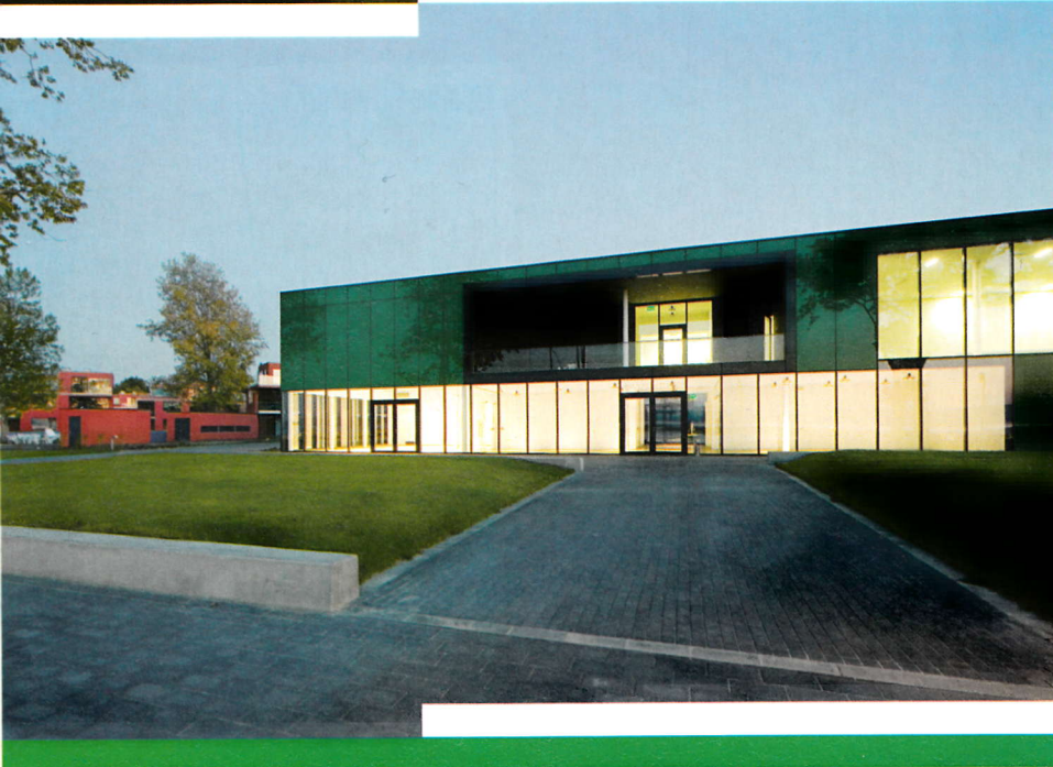
Az L alakú, zöld üveggel burkolt épület nagy, monitorablak-szerű felületekkel nyílik meg a tó és a kilátás irányába
