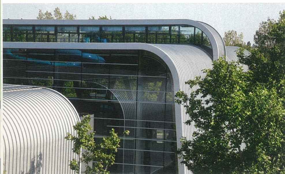
A hullám mint motívum több részletben is érvényesül. A héjalás a ThyssenKrupp Építőelemek Kft. által forgalmazott RIB ROOF 500 alumínium profilból készült
