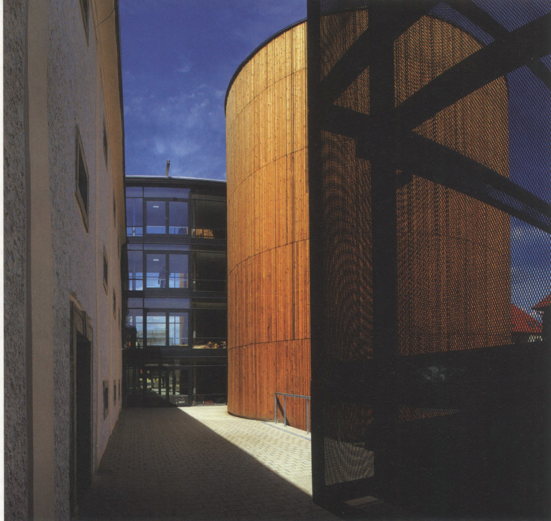
Acél-üveg nyaktaggal kapcsolódik a két silóforma épületrész a főtömeghez
