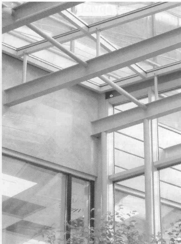
13. ábra. Külső és belső homlokzat váltása az üvegfal mentén
