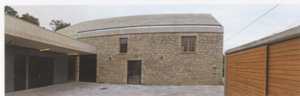
A rakott kő homlokzat és a kő tetőfedés összhangja
