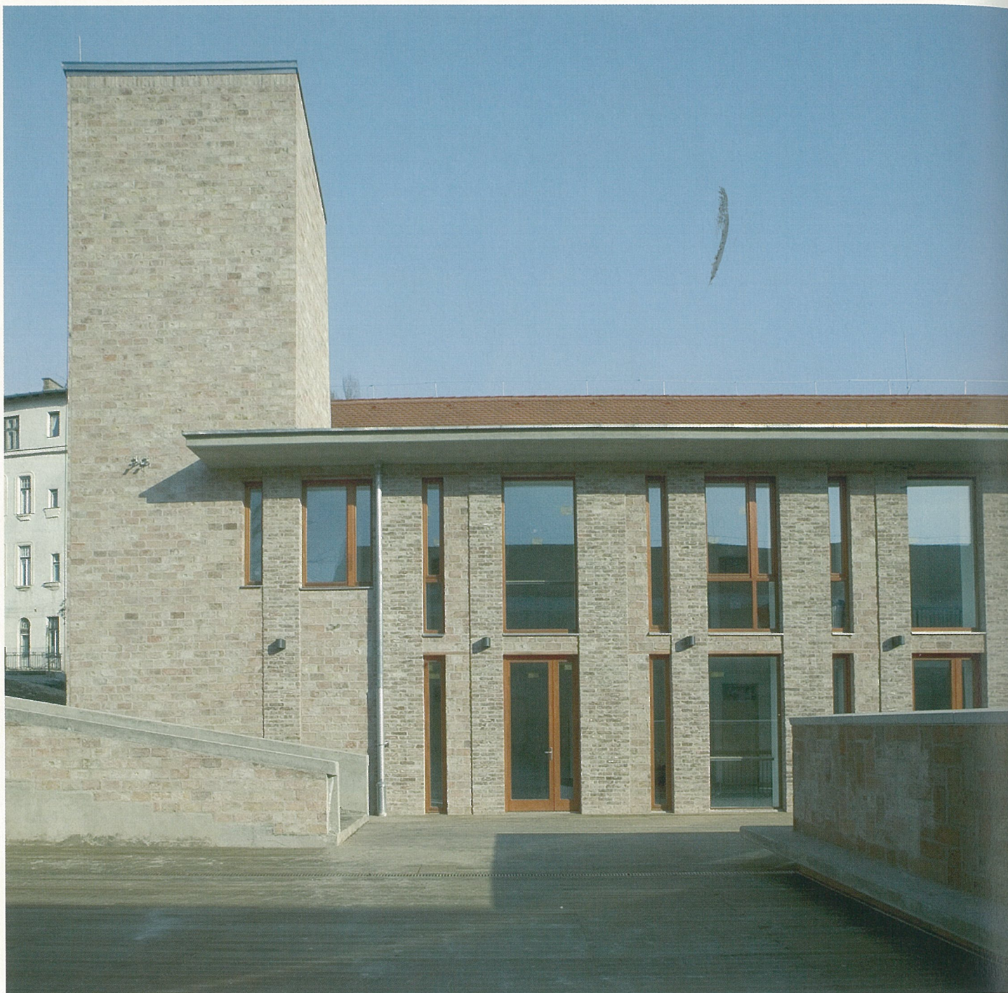
A tornaterem tetőudvarára érkező rámpa...
