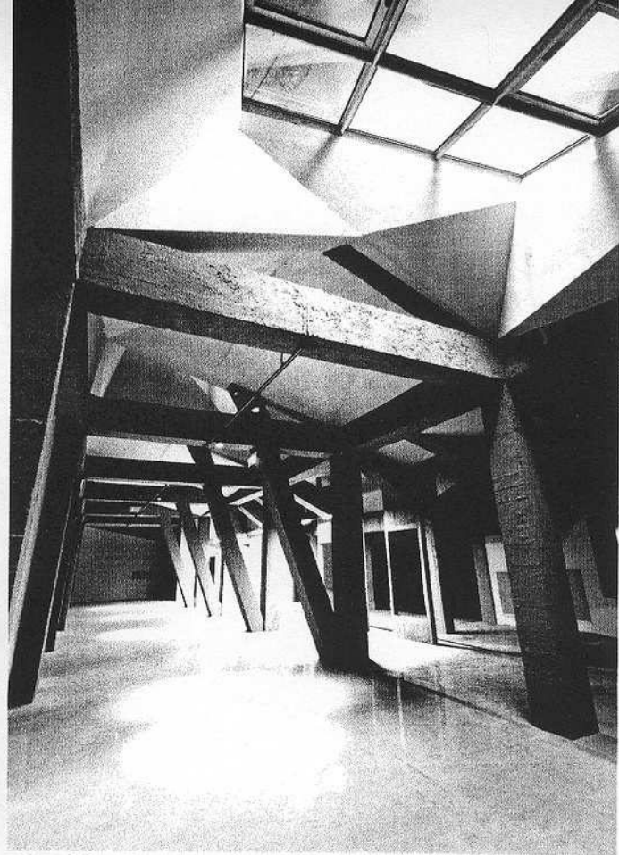
A hegy külső portlandcement-rabóc kérégbe illesztett üvegtéglákon és a vasbeton szerkezetre rálátást biztosító ablakokon keresztül érkezik a természetes fény a kiállítóterbe
