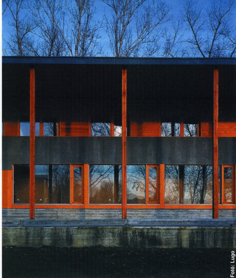
Lehetőség szerint fixen beépített ablakokat alkalmaztak
