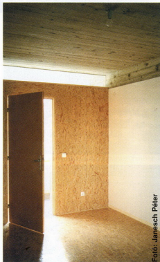
Az egyik földszinti lakószoba – OSB-burkolatokkal
